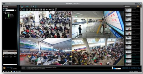
인천항 신 여객터미널 CCTV용 NVR 설치
